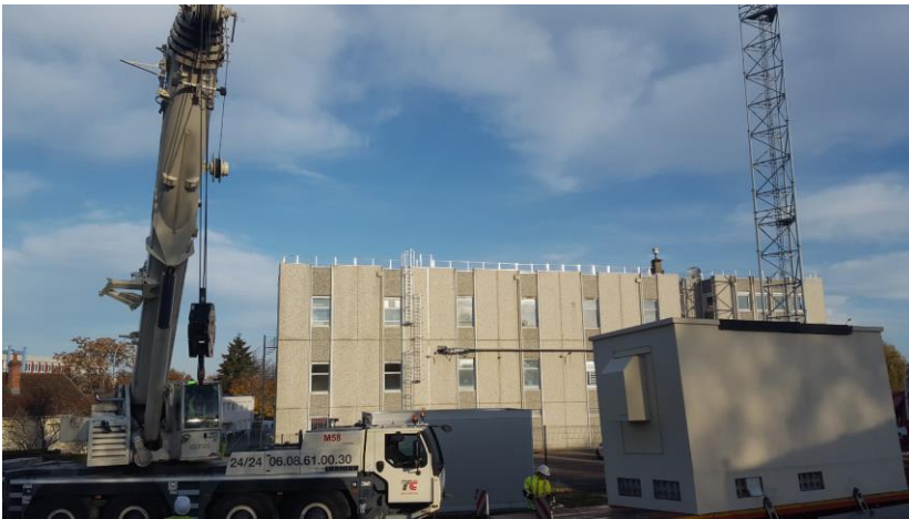
Pose du shelter rue colonel Rabier
